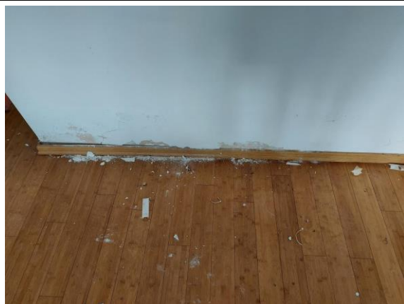
Detalj -oštećenje od curenja vode iz kupaonice
